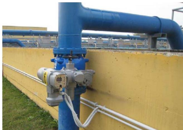
Fig.1,2 — Valvola a fusso per regolazione del flusso di aria all'interno di vasche di nitrificazione: la valvola è accessoriata con un attuatore elettrico.
